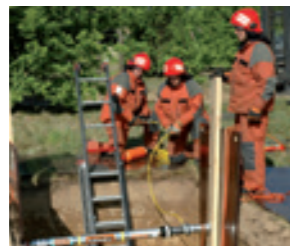
- Sauvetage dans des tranchées
