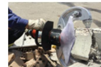
Eine perfekte Kombination: Beton mit dem CC 23 wegbrechen und Betoneisen mit dem Minischneidgerät CU 4007 oder SMC 5006 schneiden.
