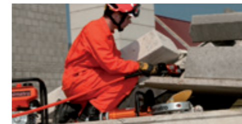
Eine perfekte Kombination: Beton mit dem CC 23 wegbrechen und Betoneisen mit dem Minischneidgerät CU 4007 schneiden.
