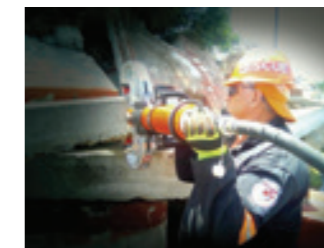
Eine perfekte Kombination: Beton mit dem CC 23 wegbrechen und Betoneisen mit dem Minischneidgerät CU 4007 schneiden.
